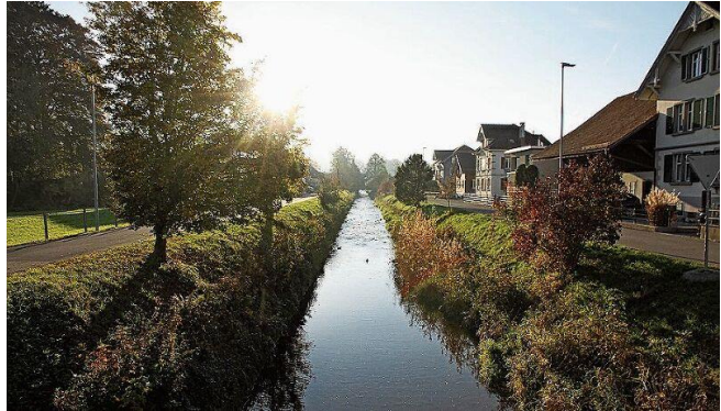
Beim Gstalden- und Freibach bestehen teils massive Hochwasserschutzdefizite. Im Bild der Freibach in Rheineck.
